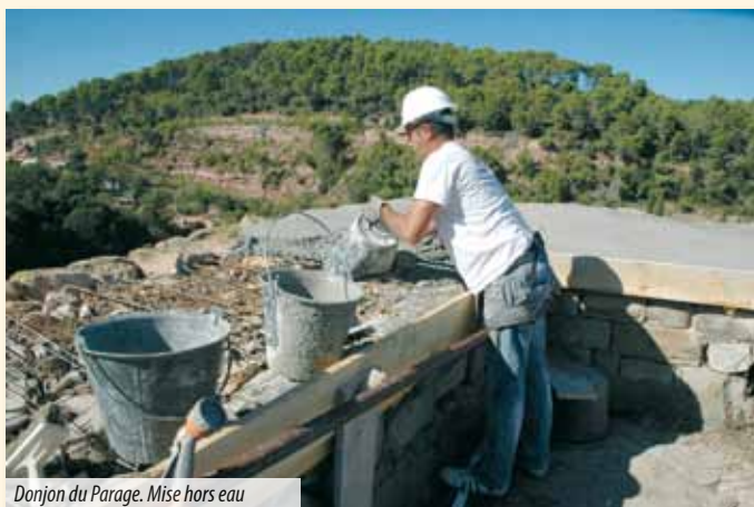
Donjon du Parage. Mise hors eau
