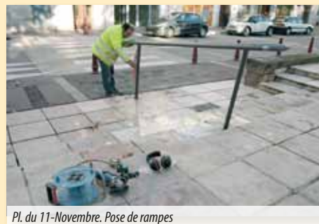
Pl. du 11-Novembre. Pose de rampes
