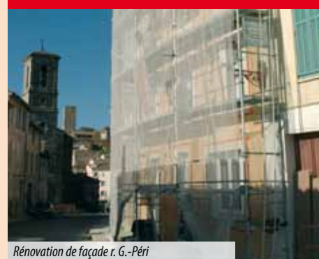
Rénovation de façade r. G.-Péri
