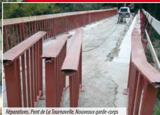
Réparations. Pont de La Tournavelle. Nouveaux garde-corps
