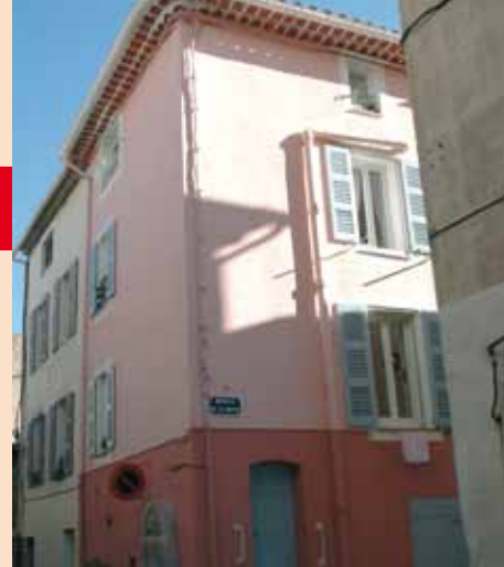
Façade rénovée r. de La Motte
