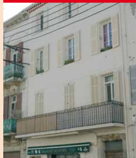
Façade rénovée ave. Gambetta
