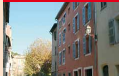
Façade rénovée r. de la République
