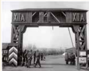
Entrée du Stalag XIII A
