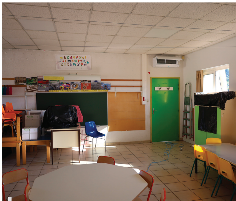
Dernière phase de travaux pour la rénovation énergétique aux écoles.
