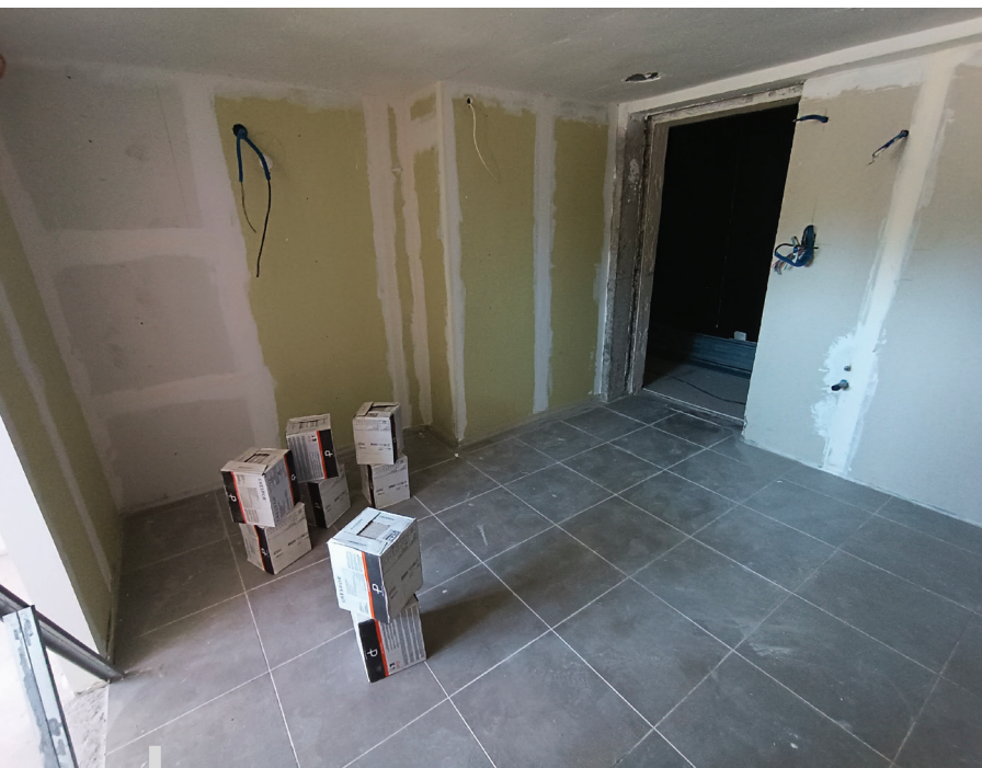
Les anciens vestiaires en cours de réhabilitation
