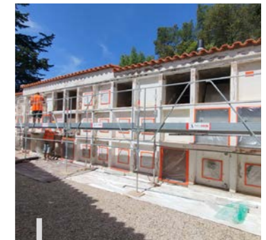
Travaux en cours
