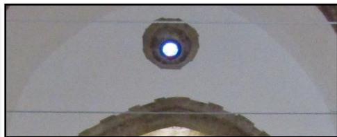
Après les travaux
