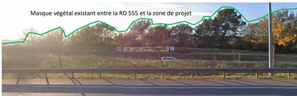
Vue depuis la RD555 vers la zone de projet
