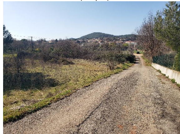
4 (voie d'accès depuis la RD91)
