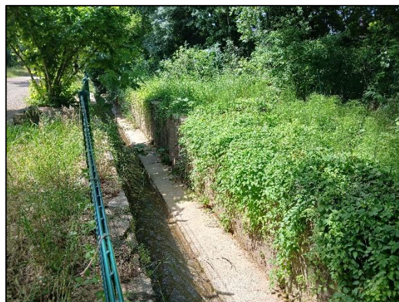
Aperçu des aménagement des berges et du lit du Réal
