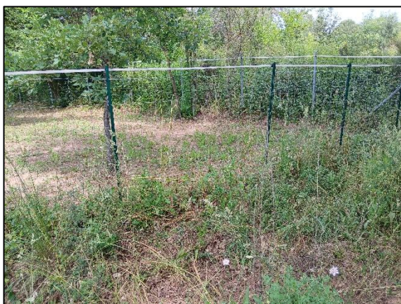
Grillage doublé à sa base restreignant voire empêchant la circulation d'individus au travers des grandes propriétés privées
