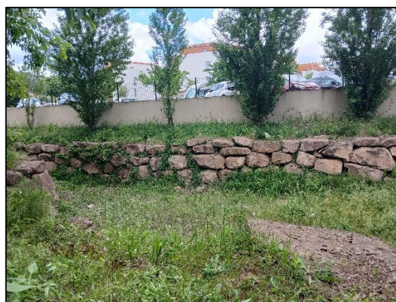
Aperçu d'un des bassins d'orage situé en périphérie des quartiers résidentiels
