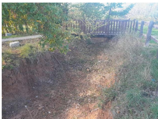
Fossé et passerelle M. BOUCAUD, 21/11/2023, Les Arcs (83)
